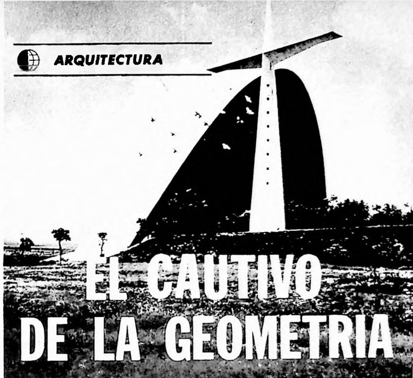
La capilla de Lomas de Cuernavaca, una de las más bellas obras realizadas por el arquitecto Félix Candela, verdadero alarde de ingeniería a pesar de la simplicidad de sus líneas.
